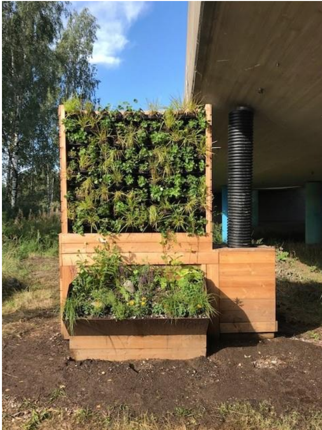
Helsingin nopeissa kokeiluissa Innogreen oy:n toteuttama hulevesiä suodattava viherseinäke.
